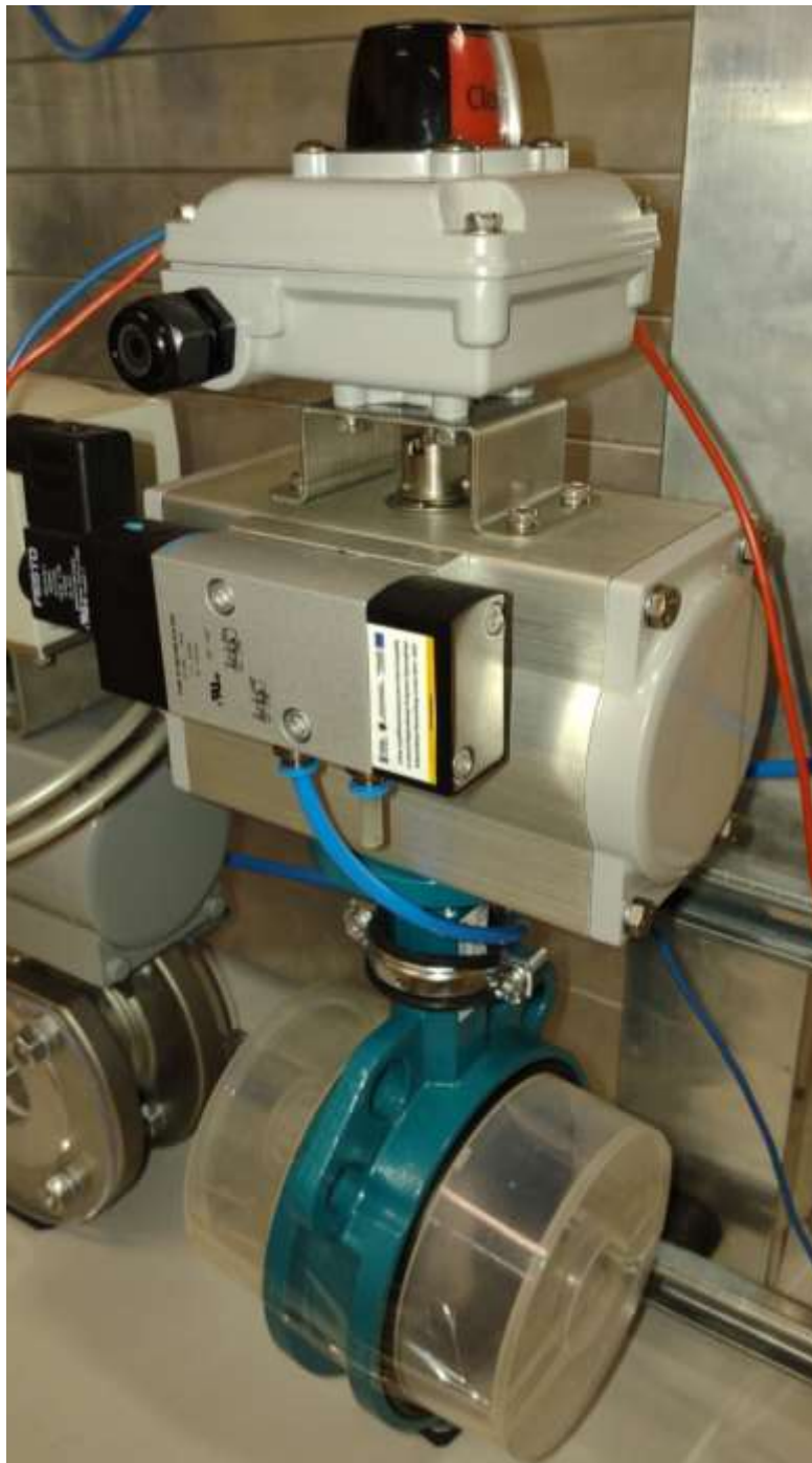
Rys. 2.3 Zawór motylkowy z aktuatorem pneumatycznym sterowany binarnie
