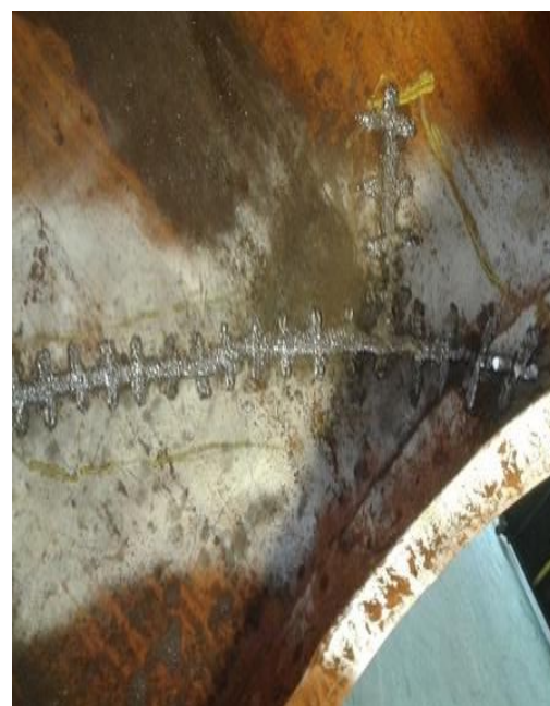
Rys. 4. Regeneracja elementu za pomocą metody Metalock
