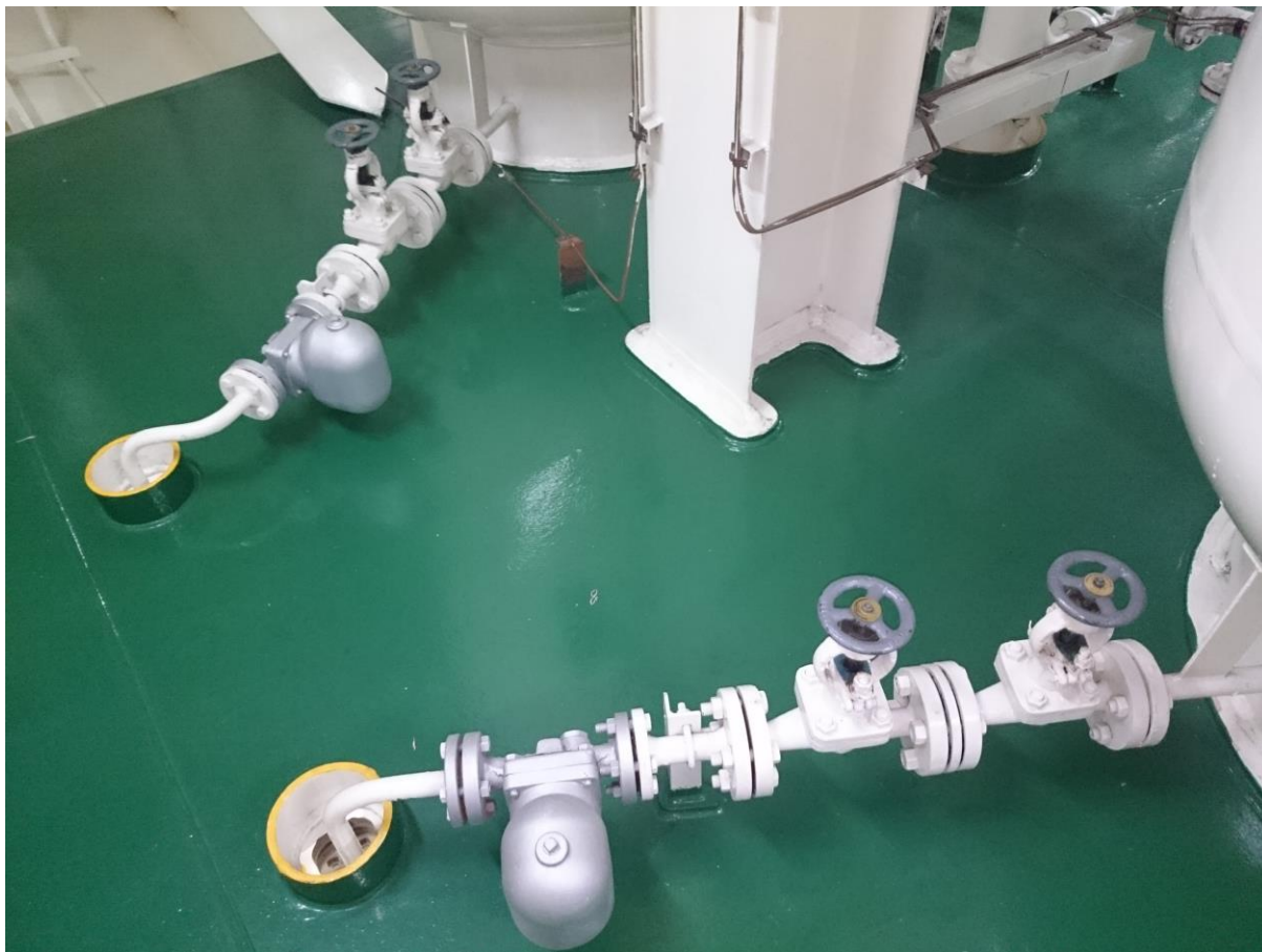
Zawory pływakowe na odwodnieniu butli startowych.
