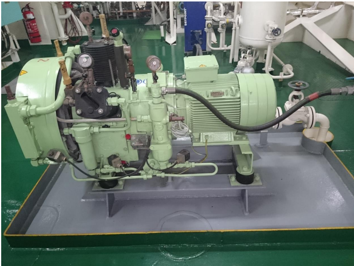
Okrętowa sprężarka powietrza startowego trzystopniowa chłodzona powietrzem.
